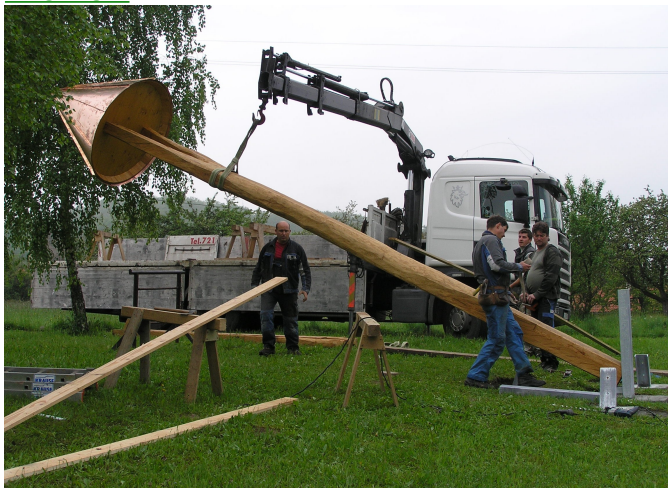
13. května byla na točně osazena zrenovovaná zvonice.
