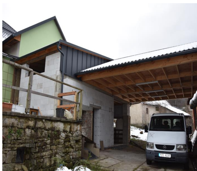
Opravy ve dvoře nemovitosti č. p. 3 (Hospoda U Zemské osy)
