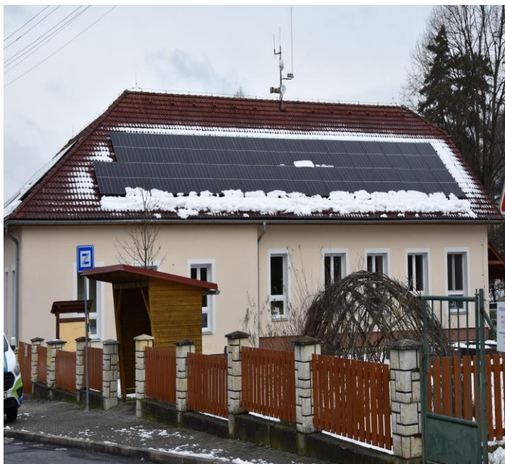
Na obecní budovy byly nainstalovány fotovoltaické panely, zde se konkrétně jedná o budovu obecního úřadu a mateřské školy
