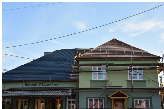
Oprava střechy na budově Hospody U Zemské osy
