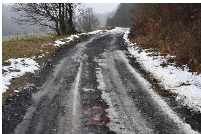
Místní komunikace Na Paseky před opravou...
